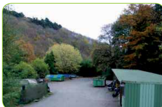
Locaux techniques et hangar
